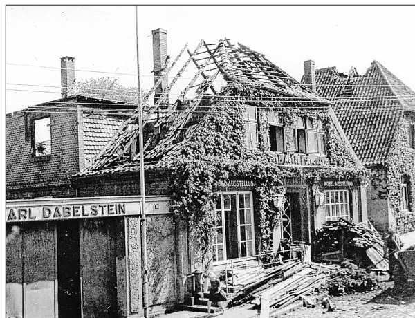
Rechts von der stark beschädigten Tischlerei stand die alte Schweinemarkt-Scheune. Die ist abgerissen.
