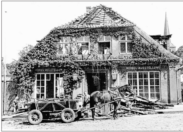
Fotos, die eigentlich verboten waren: Die Eigentümer dokumentierten die Schäden am Haus. Fotos: Privat
